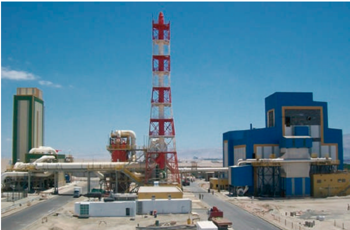
Planta procesados molibdenos Molynor (Antofagasta - Chile) Ascensores montacargas 2.000 kgs. 33 mts. recorrido con protección IP-67
