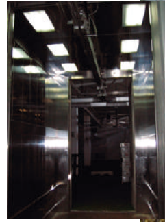
Secadero de jamones (Guijuelo - Salamanca - Spain) Ascensor hidráulico 7.500 kgs. 5mts de altura de cabina, carga suspendida
